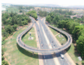
Passage supérieur pour les deux roues (Corniche de Bamako - Mali)
