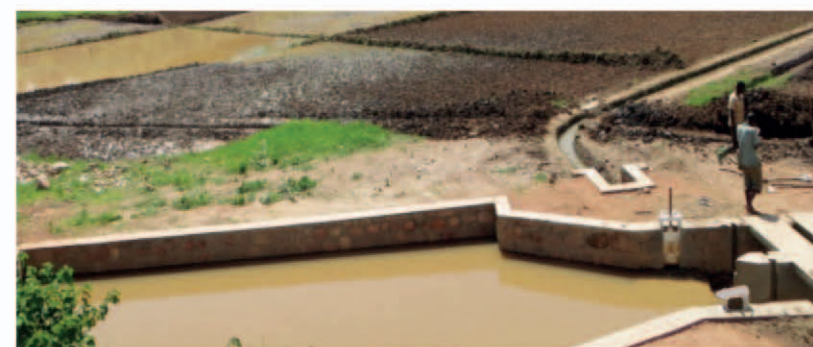
Aménagement hydro-agricole des marais de Rugamura, kabuyengue et Nyavyamo (Burundi)
